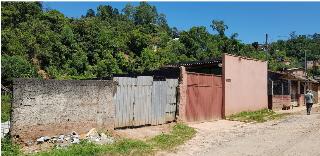
Figura 6 – Foto da rua Iti Sakai, onde ocorrem alagamentos por falta de estruturas de microdrenagem
