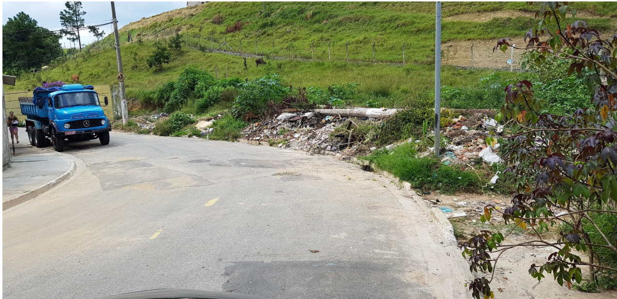
Figura 32 – Descarte de material sobre um talvegue no Jardim Margareth (Data: 20/02/2019)
