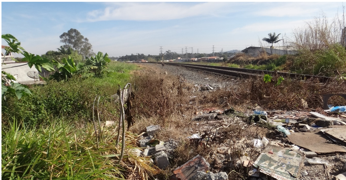
Figura 7 – Trecho de canal entupido com entulho no Jardim Belém Urbano
