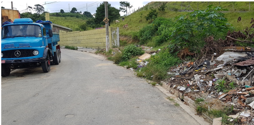
Figura 5 – Foto do Jardim Margareth, onde ocorrem alagamentos por falta de drenagem
